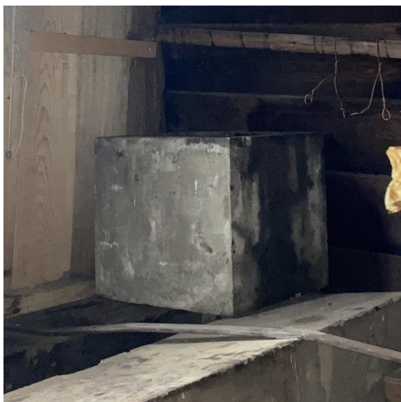
Betonnen bak voor bluswater (Gelkenes Molen)
