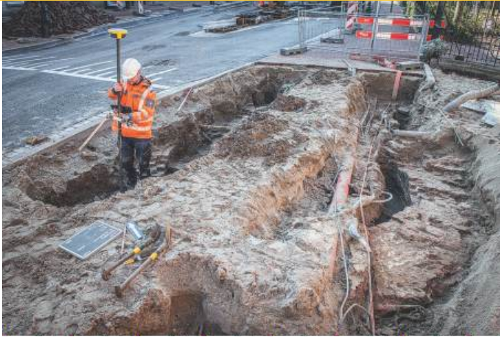
De fundering van de noordelijke toren. (Foto: IDDS)
