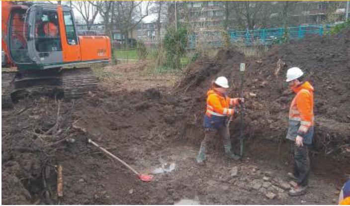
Sfeerfoto van de veldwerkzaamheden. (Foto: RAAP)
