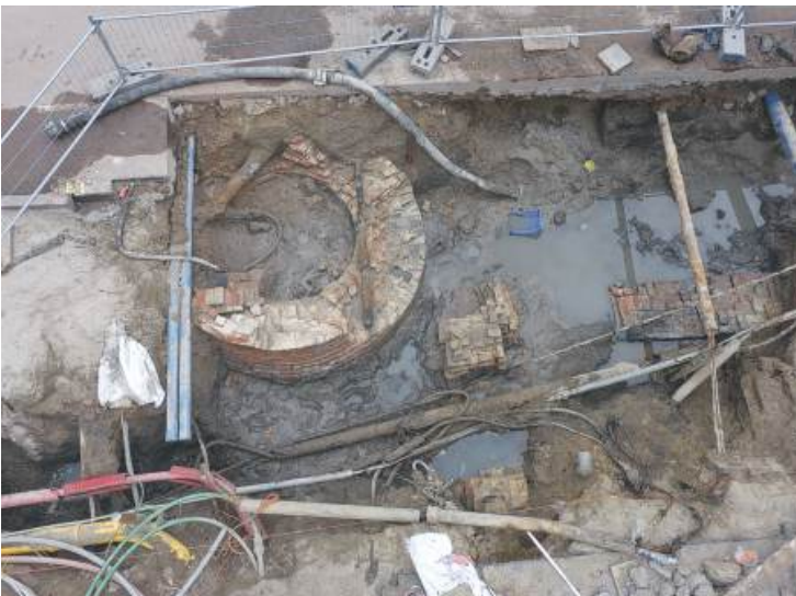
De kleinere fundering van een binnentoren. (Foto: IDDS)
