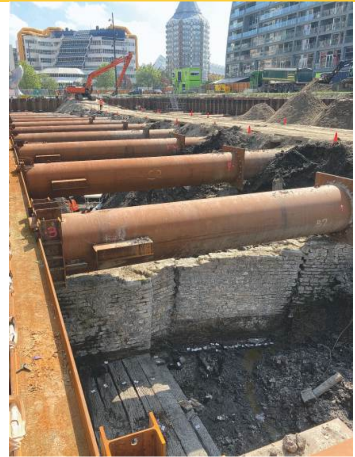
Impressie van de bouwkuip met op de voorgrond de oostelijke muur van de sluisvliet van de Zevenhuizer sluis met een gedeelte van de houten sluisvloer.
