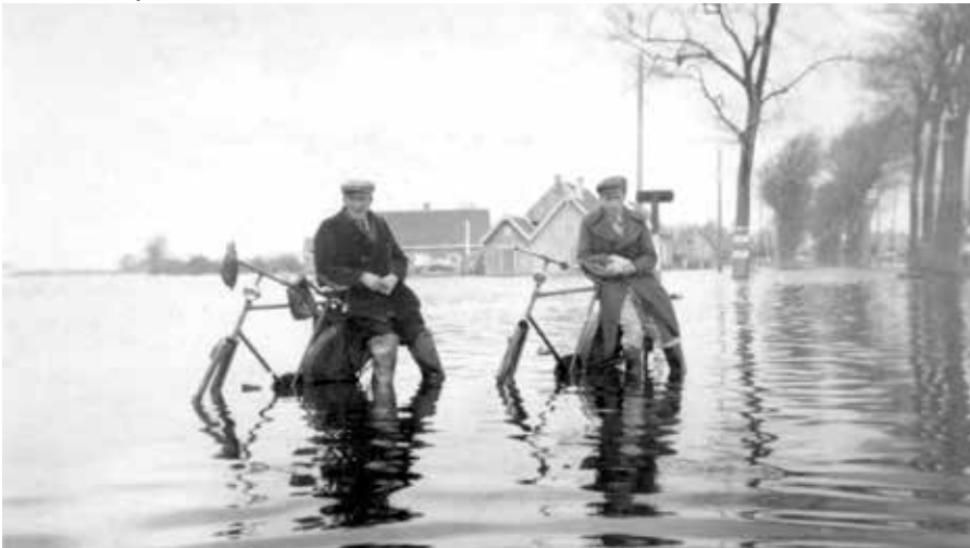
Inundatie bij Hellevoetsluis
