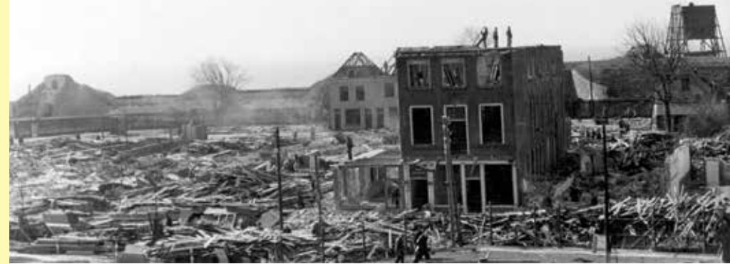
De sloop van de linkerkant van de vesting is begin 1944 in volle gang
