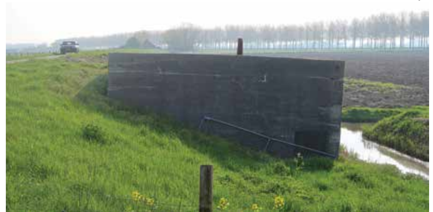
Telefoonschakelbunker in de dijk
