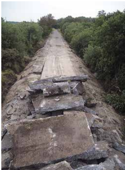
De sloop van de Duitse betonweg
