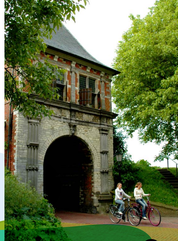
Oude poort in de stadswal van Schoonhoven
