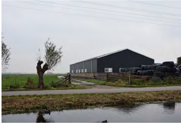
Te harde overgang naar omgeving en rommelig voorerf
