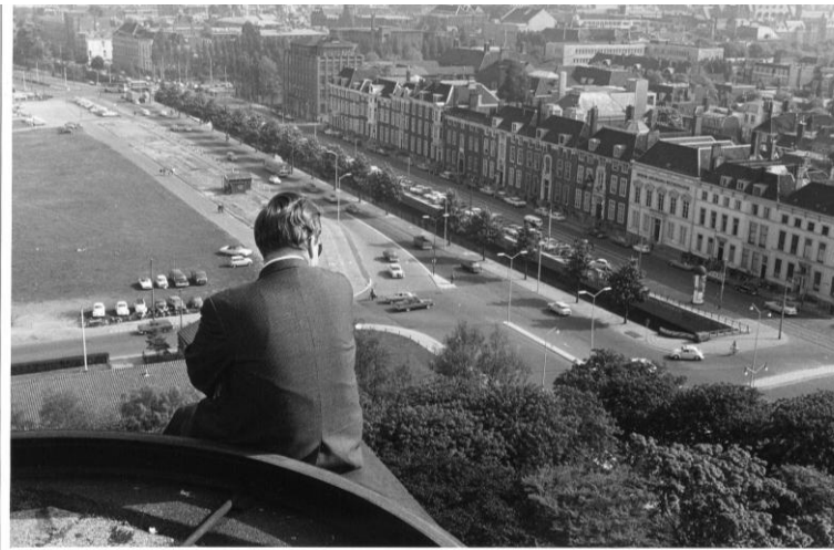
Panorama ged. Den Haag gezien v.a. het dak
