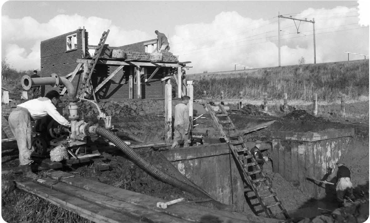
Bouw van het stoomgemaal in de Tweemanspolder, 1951 (Collectie Nationaal Archief CC 0)
