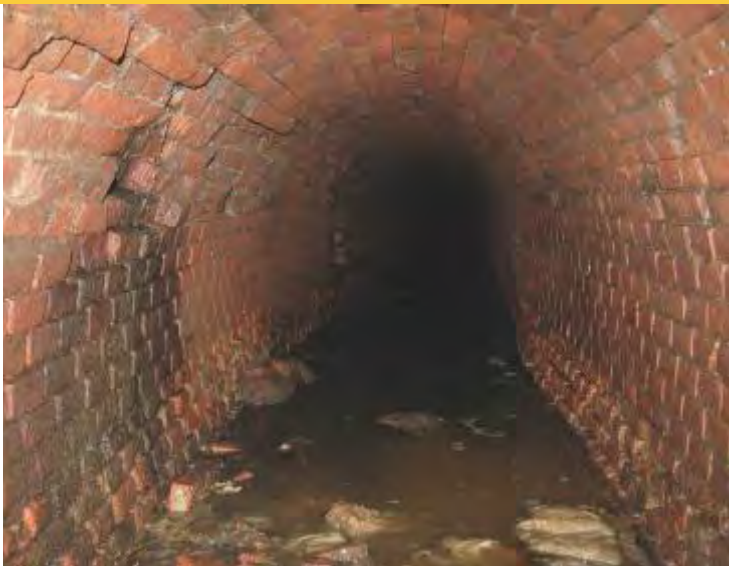
Foto van de binnenzijde van het gemetselde riool, gemaakt met een drone voorafgaand aan de opgraving.
